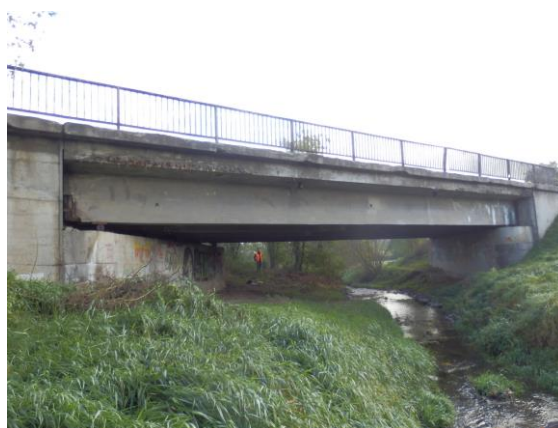
Obr. 13.17.: Silniční most ev.č. 57-016 přes místní vodoteč u obce Holasovice u Opavy, stav k srpnu 2011.
