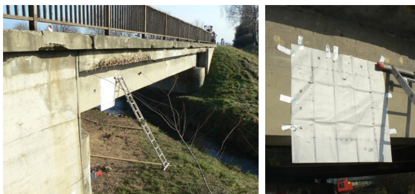
Obr. 13.21.: Celkový pohled a detail umístění měřícího rastru při jednom ze série měření na bočním líci krajního trámu.
