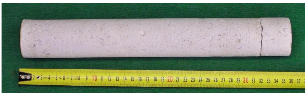
Obr. 13.4.: Vzorek betonu odebraný ze soklu jádrovým vrtáním – jádro bylo kompaktní, trhlinka byla způsobena vylomením jádra.
