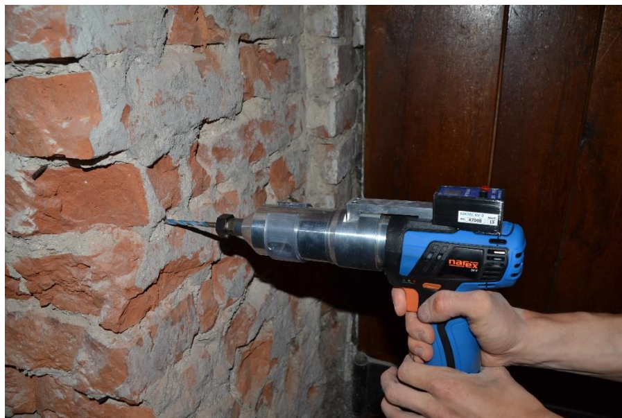
Obr. 10.7.: Provádění zkušebních vrtů přístrojem KV3.
