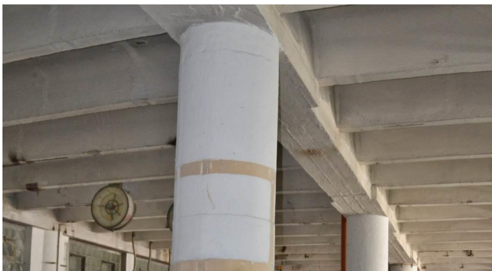
Obr. 7.20.: Průvlak o šířce 500 mm mezi sloupy monolitického skeletu průmyslové haly.
