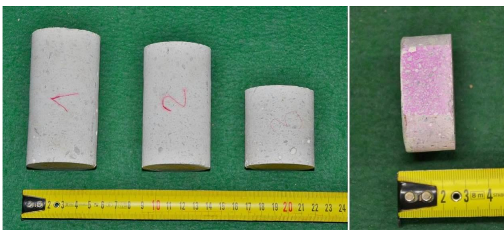
Obr. 13.5.: Zkušební tělesa vyrobená z vývrtu do soklu; vpravo fenolftaleinový test na povrchové části jádra, karbonatace betonu je naprosto minimální.
