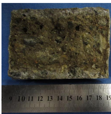
Obr. 2.23.: Pomocí \text{AgNO}_3 stanovená hloubka průniku chloridů.
