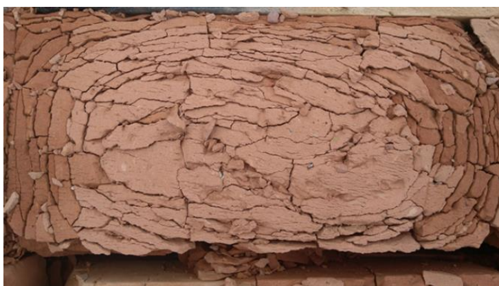
Obr. 9.6.: Detail destrukce vzorku cihly po zmrazovacích cyklech – typický projev tzv. textury.
