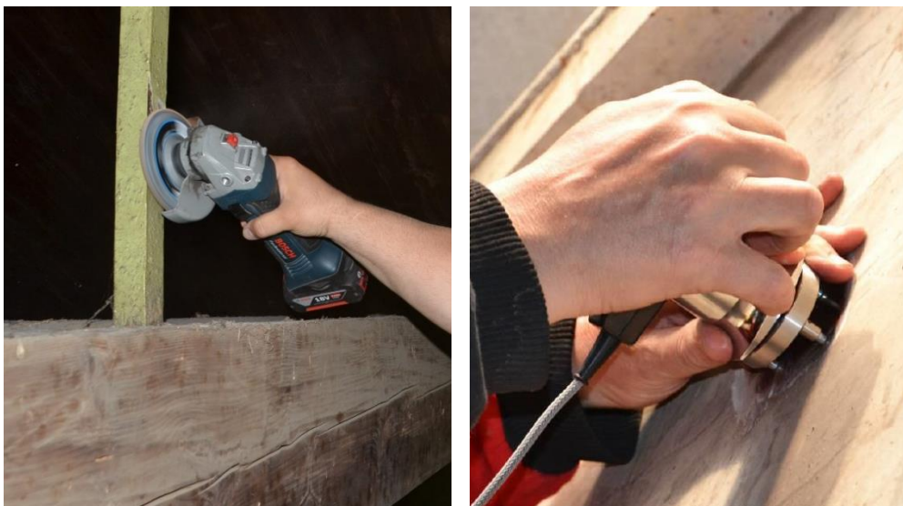
Obr. 6.8.: Příprava povrchu obroušením nátěru (vlevo) a vlastní provedení zkoušky zatlačáním přístroje silou 50 N po předepsanou dobu.
