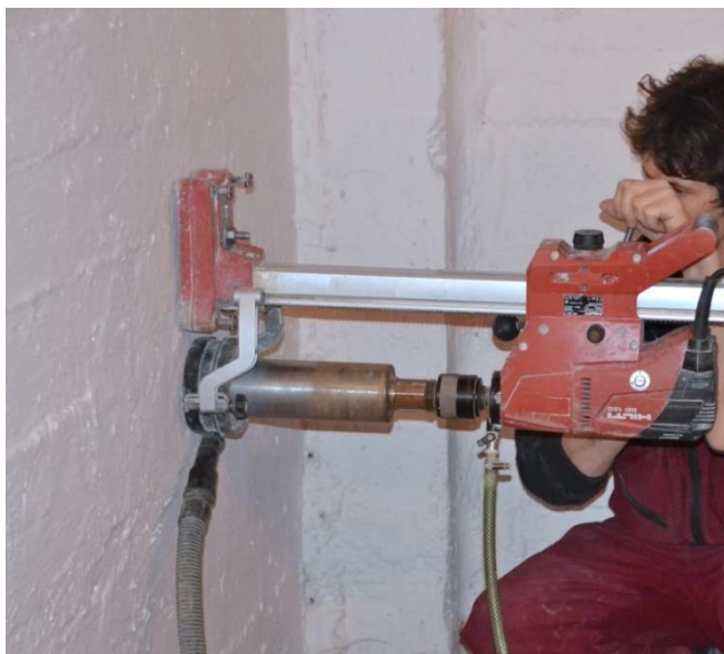
Obr. 5.1.: Odběr jádrového vývrtu z konstrukce pomocí vrtné soupravy za mokra – voda je přiváděna hadicí do vrtačky a přes dutý vrták chladí vrtací korunku a současně vyplachuje odvrtný materiál (na snímku vrtání přes pružnou manžetu a odsávání vody vysavačem).
