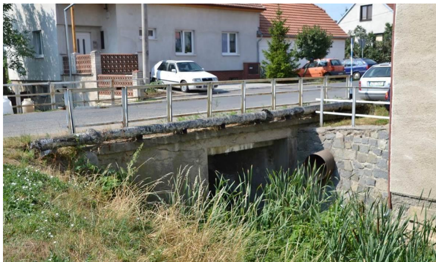
Obr. 7.5.: Pohled ze severovýchodu na most přes místní potok v obci Nosislav
