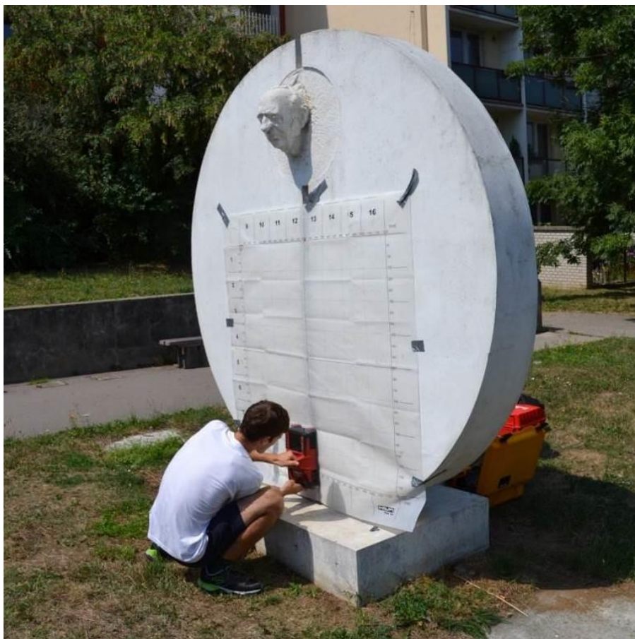
Obr. 13.7.: Stanovení množství a polohy výztuže v dolní části plastiky pomocí radaru Hilti PS 1000 – použit nalepený rastr o rozměrech 1,20×1,20 m.
