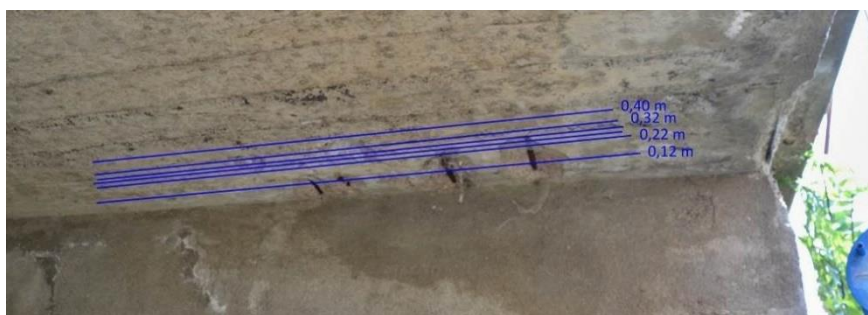
Obr. 7.6.: Pohled na desku nosné konstrukce s vyznačenými liniemi skenování.
